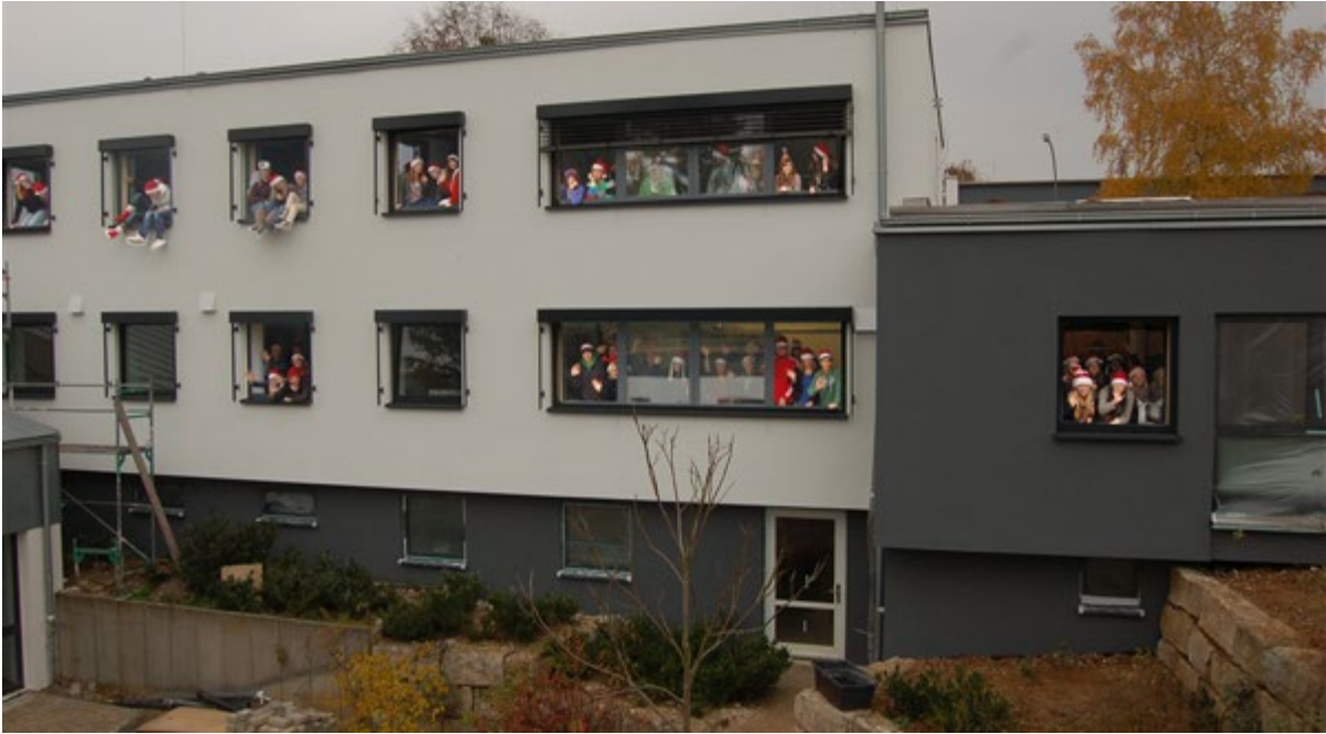
und "Belagerung" der Fenster der Verwaltung und der Bibliothek - der "Weihnachtsfotograf" befindet sich auf dem Grasdach der Naturwissenschaften.
